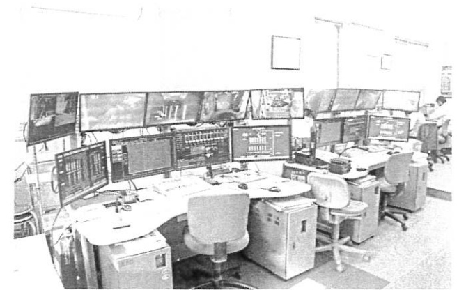
各プラントの計量操作盤を「LIBRA a」の最新機種に更新
