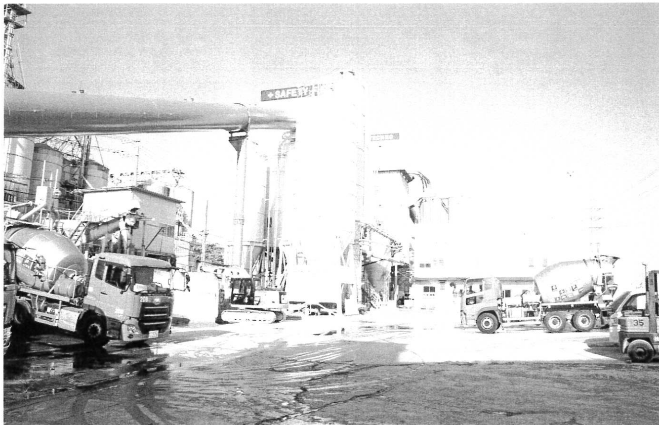
手前がBプラント、奥がAプラント。右は操作室や試験室を併設した事務所
