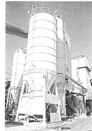
粉体サイロをA、B両プラントで共用できるように改造した
